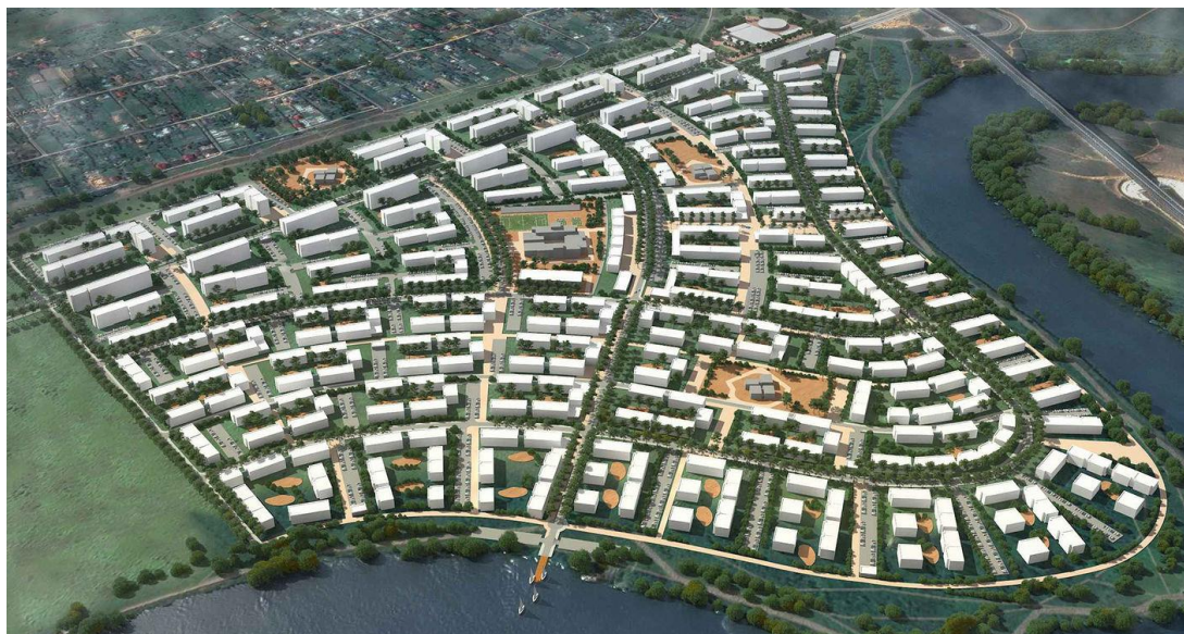
Рисунок 12. Общий вид на жилой район
